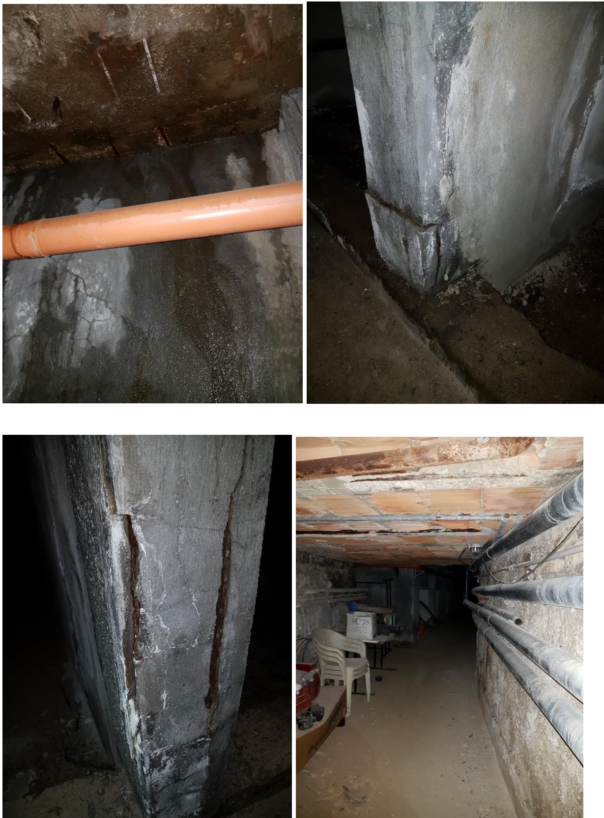
Figura 43: L'ispezione del piano interrato sottovasca ha evidenziato infiltrazioni provenienti dalla vasca superiore, infiltrazioni che hanno innescato fenomeni di espulsione del copriferro;
