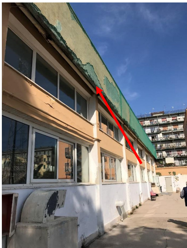
Figura 2-5: espulsione del copriferro delle strutture dovuto all'ossidazione delle armature interne;
