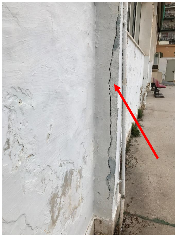
Figura 2-5: espulsione del copriferro delle strutture dovuto all'ossidazione delle armature interne;
