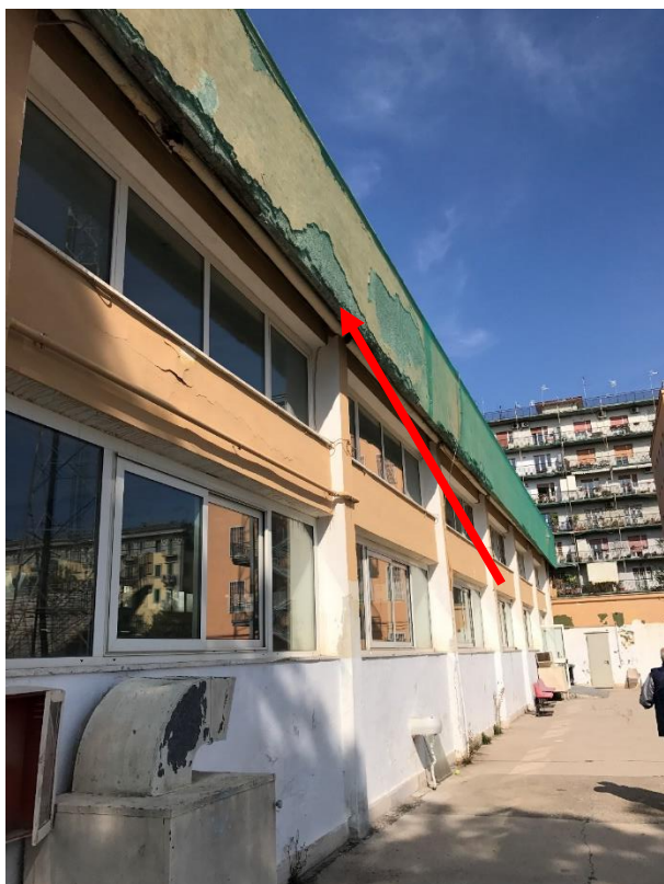
Figura 3-5: espulsione del copriferro delle strutture dovuto all'ossidazione delle armature interne;
