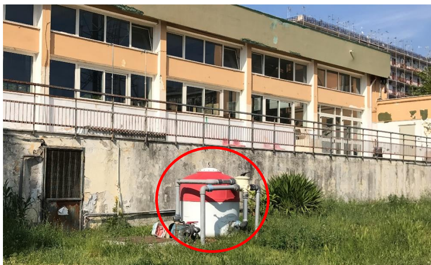
Figura 10: Sistema di filtraggio a sabbia con pozzetto di raccolta acque dalla vasca, filtraggio delle stesse ne reimmissione in vasca;
