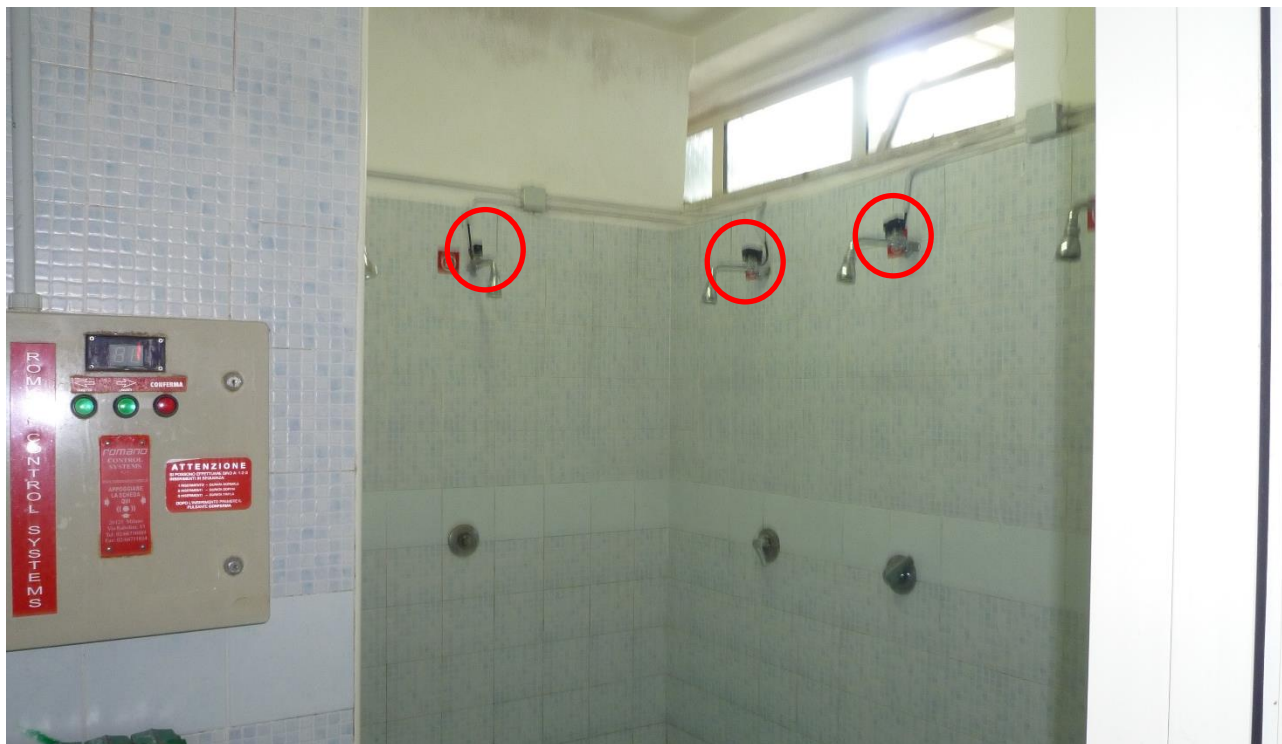
Figura 9: Sistema elettrico al di sopra delle docce;
