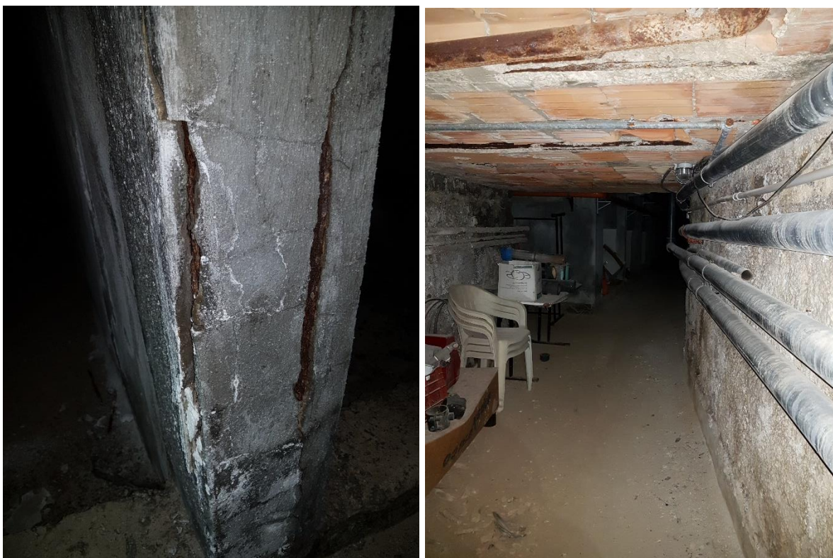
Figura 33: L'ispezione del piano interrato sottovasca ha evidenziato infiltrazioni provenienti dalla vasca superiore, infiltrazioni che hanno innescato fenomeni di espulsione del copriferro;
