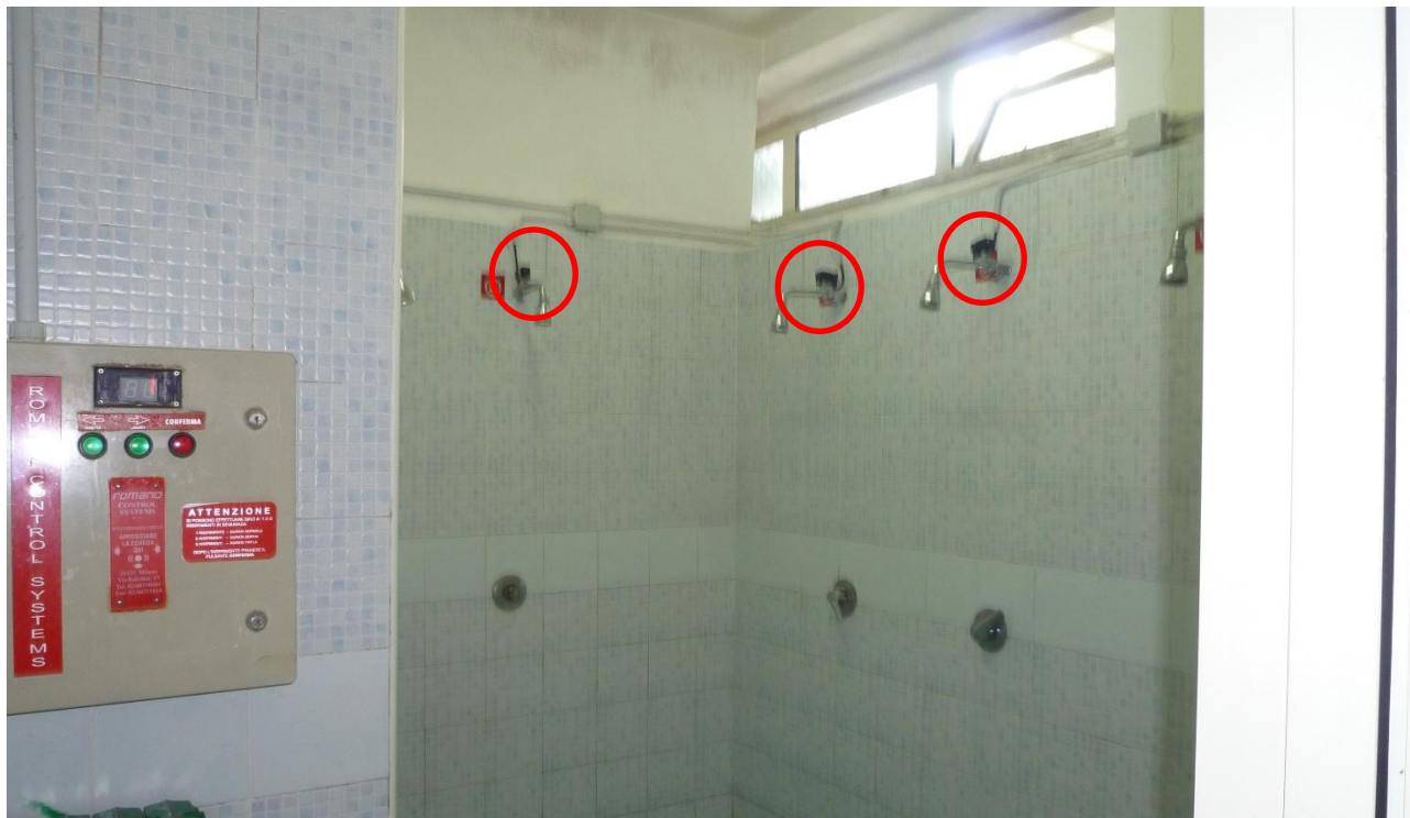
Figura 9: Sistema elettrico al di sopra delle docce;
