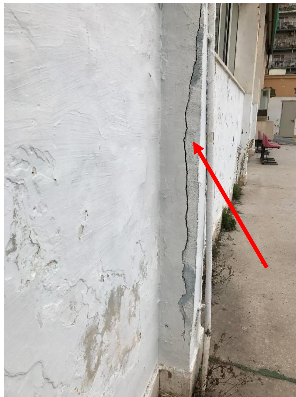
Figura 3-5: espulsione del copriferro delle strutture dovuto all'ossidazione delle armature interne;
