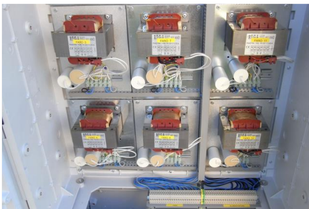
Figura 7: Esempio di alimentatori in armadi per esterno
