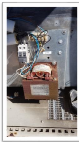
Figura 4: Quadro elettrico torre faro esistente
